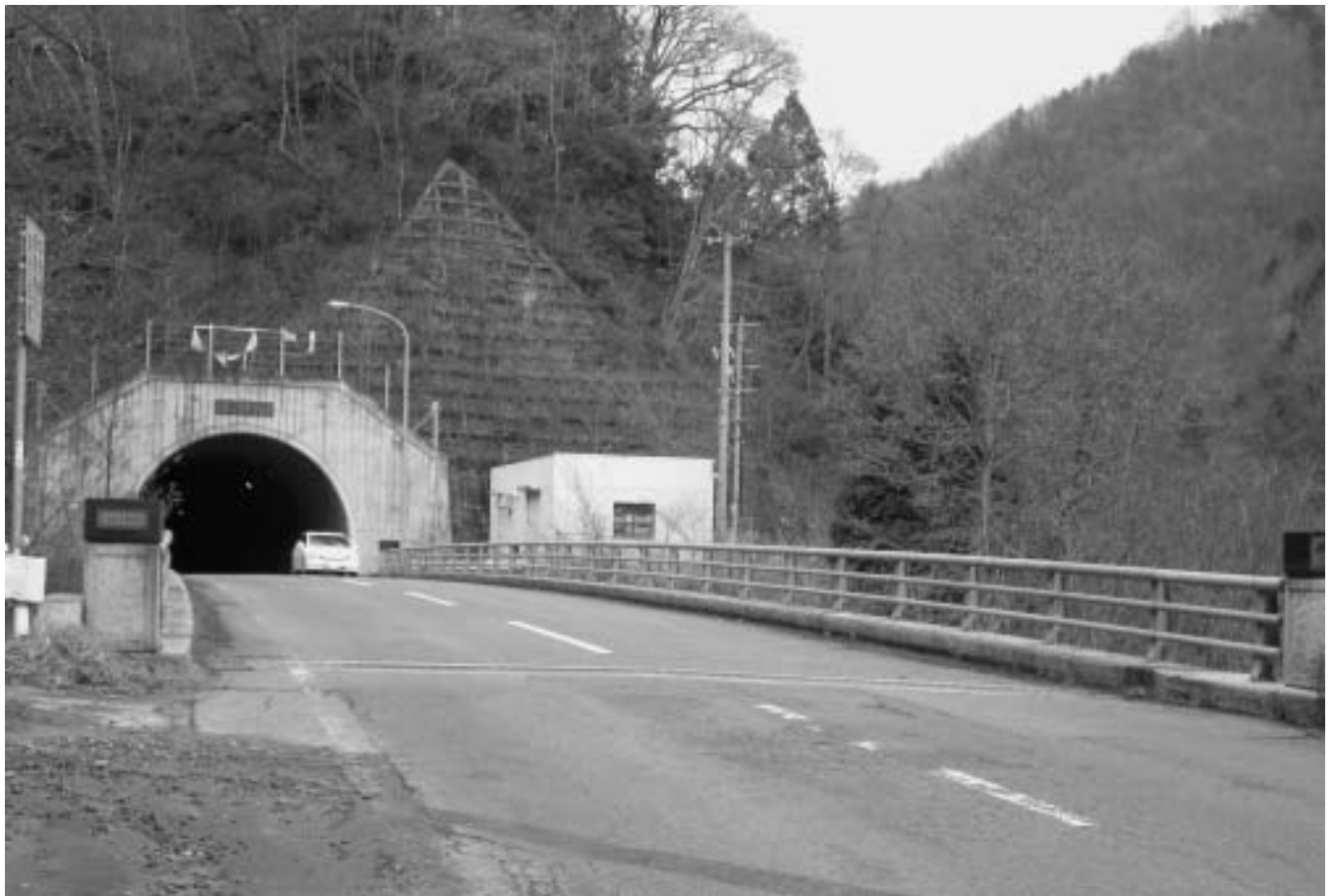
標高400 ㍎ を超える場所に位置する南昌第一トンネル=矢巾町側から撮影
